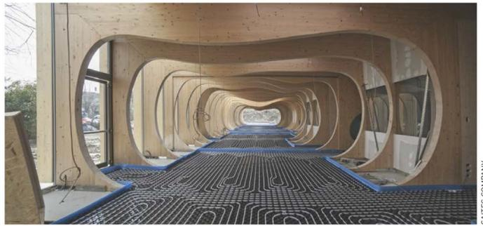
LE SUPERFICI RADIANTI sono distinte per zone: in ognuno degli ambienti la temperatura è regolata tramite termostati, mentre il rinnovo igienico dell'aria è garantito da recuperatori di calore a flussi incrociati.
