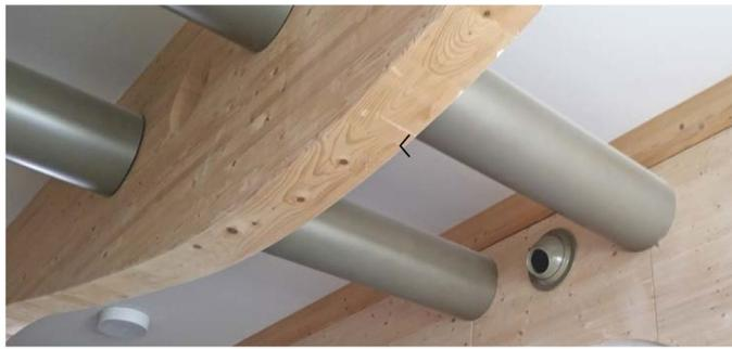
L'IMPIANTO DI VENTILAZIONE, parte integrante delle tecnologie installate: si nota la bocchetta orientabile per l'aria e, ai lati, le reti impiantistiche a soffitto celate da carte metalliche.
