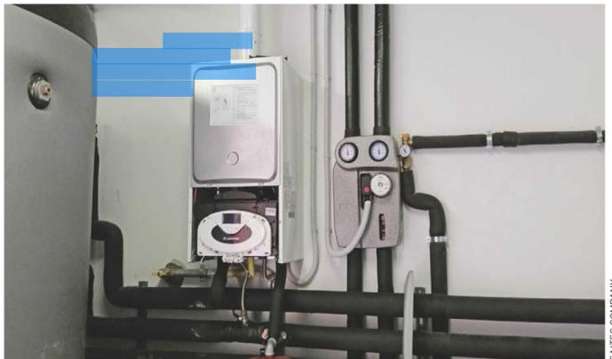
LA PRODUZIONE dei fluidi caldi per la climatizzazione e l'ACS è affidata rispettivamente a una pompa di calore acqua/aria e all'impianto solare termico: una caldaia a condensazione a gas integra il fabbisogno termico.
